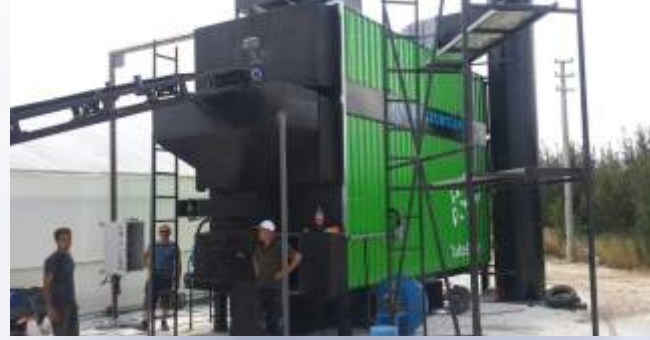
BULGAN TARIM – 4.000.000 Kcal/h kapasiteli tam otomatik sıcak su kazanı komple ısı merkezi ANTALYA/Elmalı
