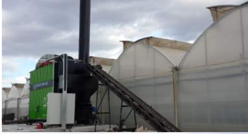
MOPAŞ SERACILIK –4.000.000 Kcal/h kapasiteli tam otomatik sıcak su kazanı komple ısı merkezi MANİSA/SALİHLİ
