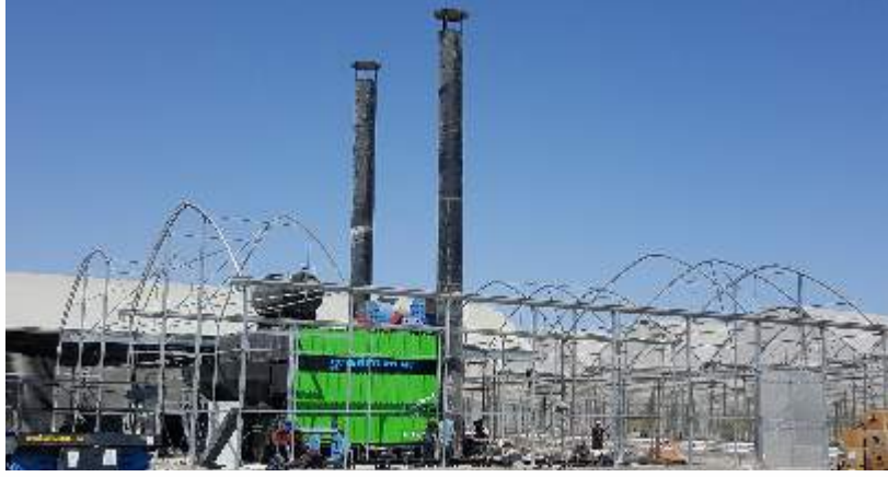
OSC TARIM – 2 Adet 2.500.000 Kcal/h kapasiteli tam otomatik sıcak su kazanı komple ısı merkezi ÖZBEKİSTAN/Taşkent
