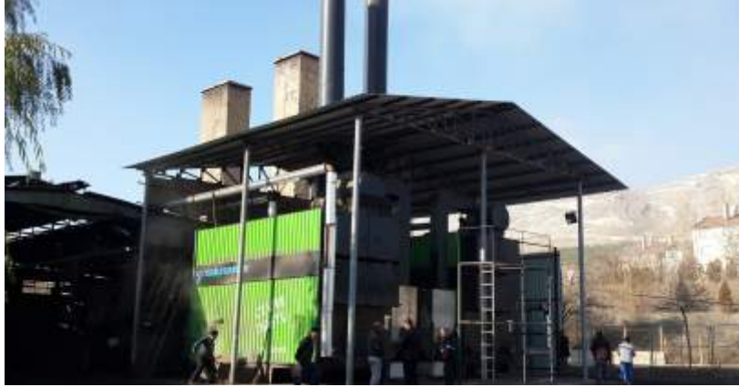
PARK TERMİK - 4 ADET 4.000.000 Kcal/h kapasiteli tam otomatik sıcak su kazanı komple ısı merkezi ANKARA/Çayırhan
